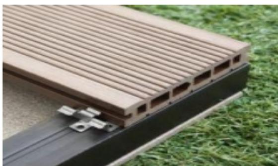
Установите вторую доску, вставив пазом в кляймеры (зазор между досками не менее 5 мм, не должен сокращаться подручными средствами (молоток, киянка) только физическим усилием руки).
